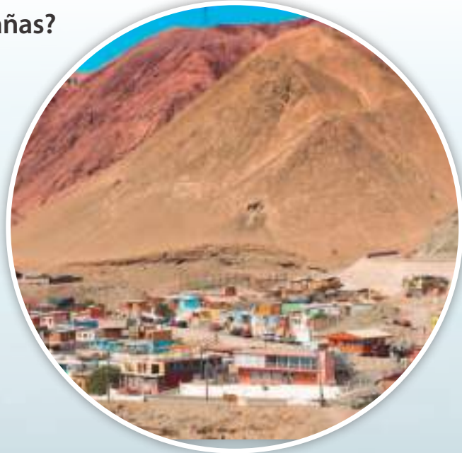
▲ En la ciudad de Antofagasta, muchos asentamientos se emplazan en laderas de cerros.
