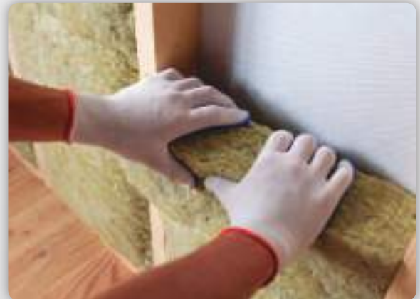
▲ En los muros de las casas se emplean aislantes como la fibra de vidrio. Esta disminuye la transferencia de calor desde la casa al exterior en invierno y desde el exterior a la casa en verano.
